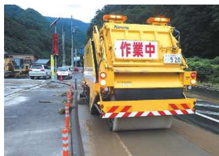
令和6年7月に発生／山形県の豪雨災害 最上町瀬見地内にて路面清掃実施。
